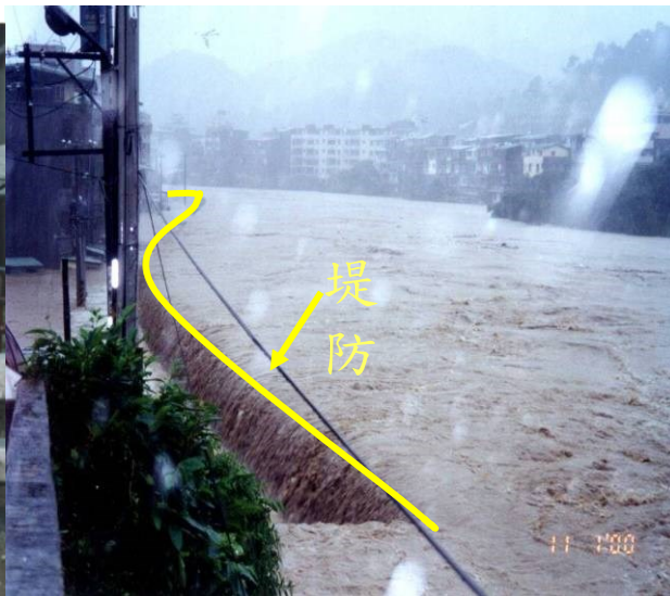
外（洪）水溢堤倒灌入侵
