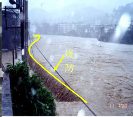
外（洪）水溢堤倒灌入侵
